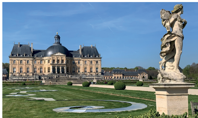
Le Château (façade sud)
